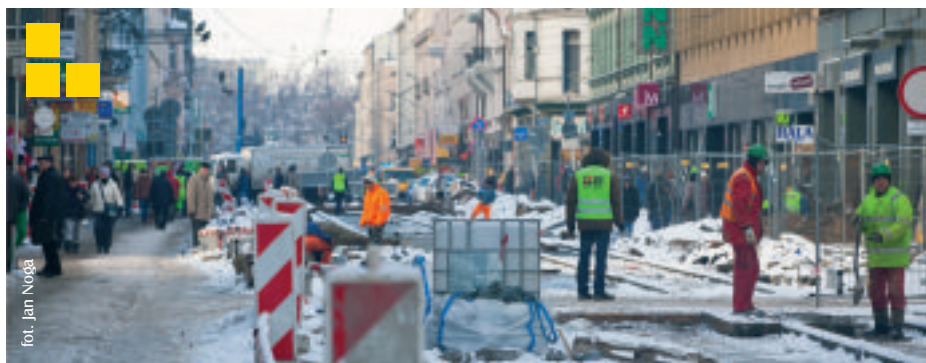
Prace remontowe na ulicy 3 Maja, grudzień 2012.
