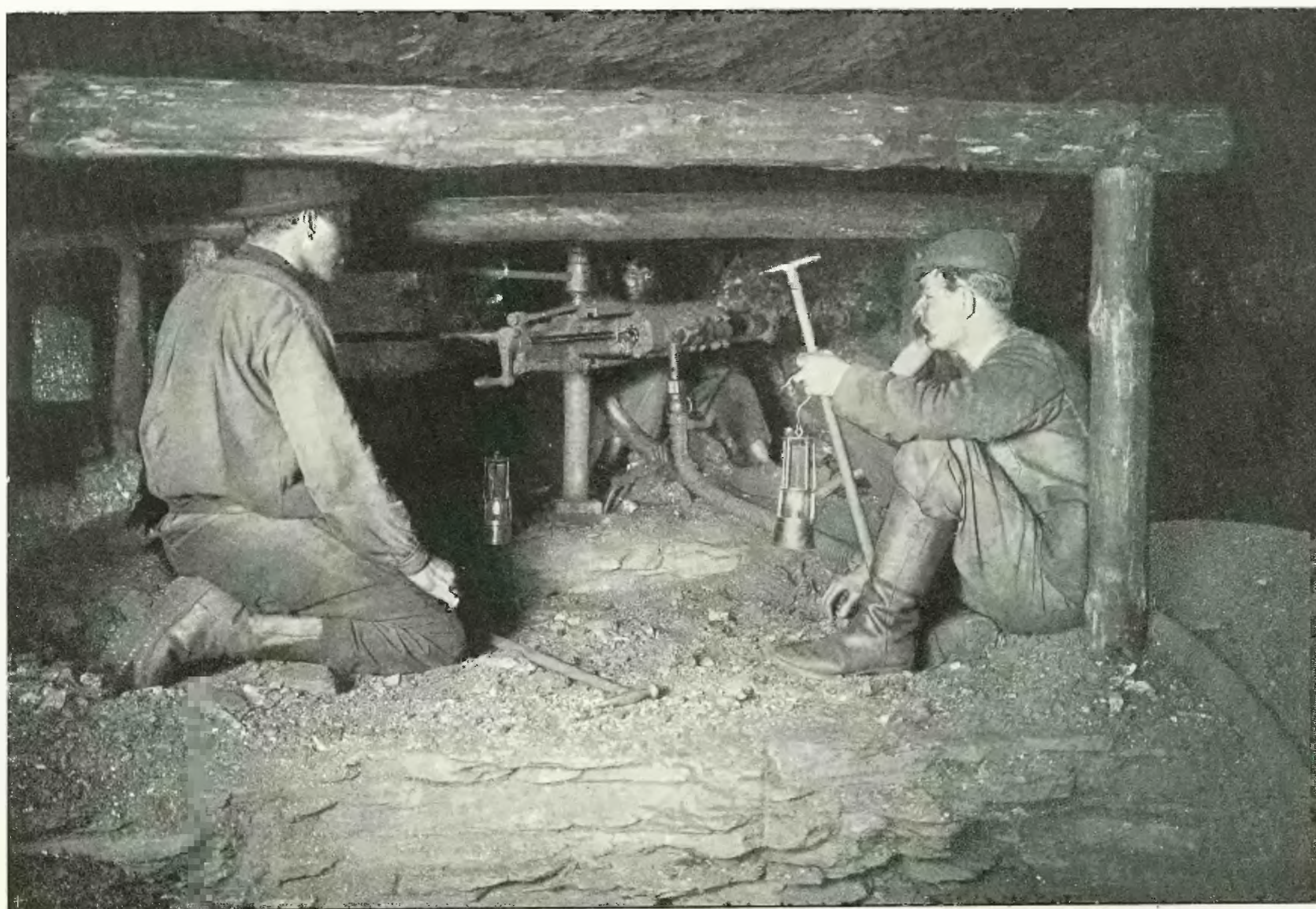
DANS UNE MINE DE WESTPHALIE. — Au front de taille : havage mécanique.
