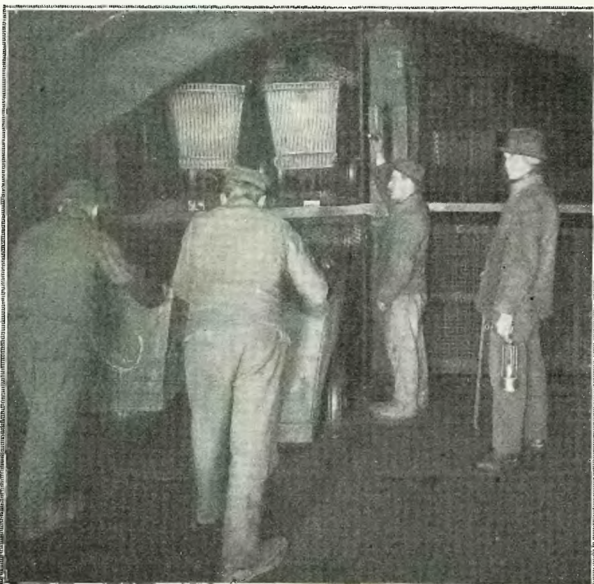
Chargement des berlines dans la cage. — Phot. Zirkler.
