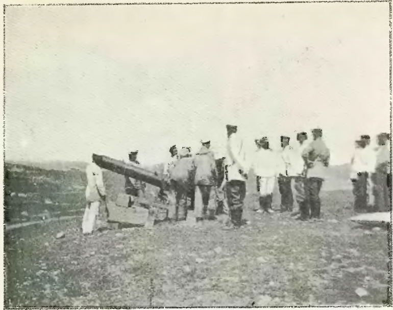
Un tube lance-torpilles monté sur un affût.
