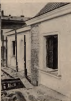
Wyprawa ścian zewnątrznych
