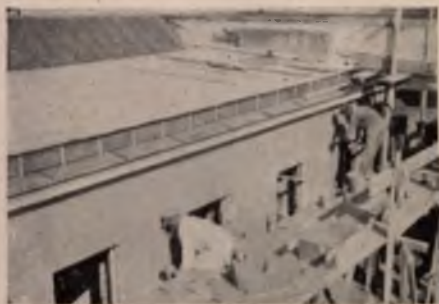
Wyprawa ścian zewnątrznych
