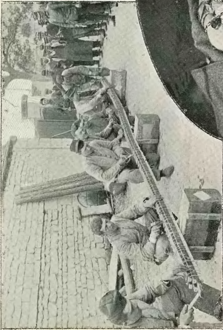
Les soldats du 6 e génie, commandés par le lieutenant Lefrançois, disposent, sur des lattes de 6 mètres, 350 pétards de 135 grammes de mélinite.
