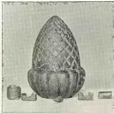
La « pomme de pin », avec les foudons et les écrous de fermeture.
