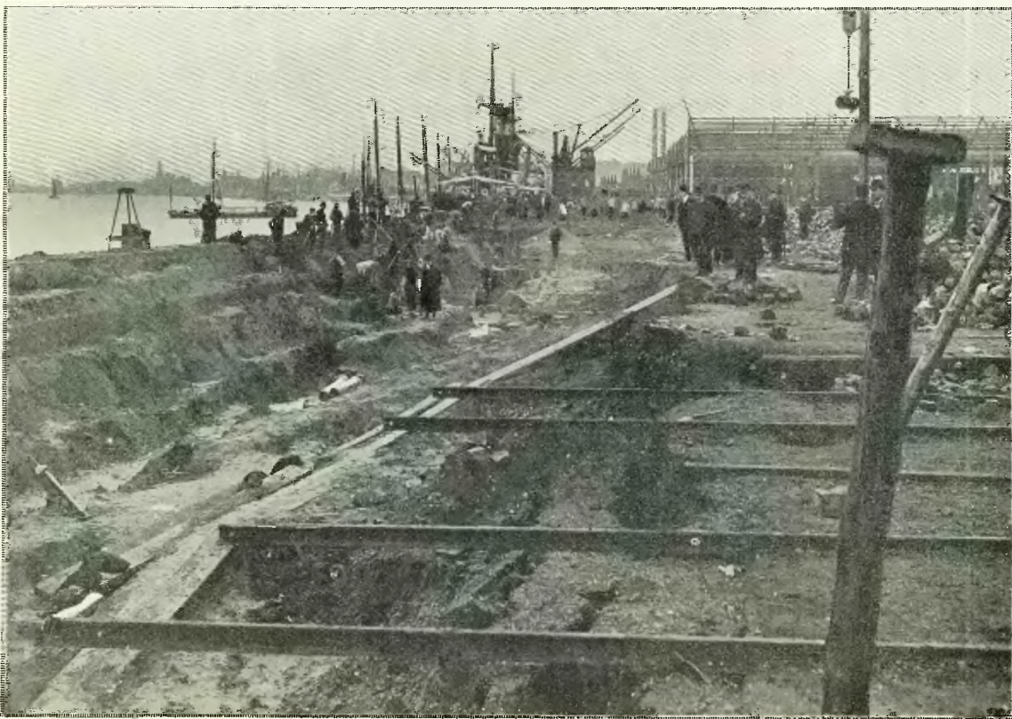
A Anvers : une crevasse produite par le glissement des quais dans le port. — Phot. A. Piere.
