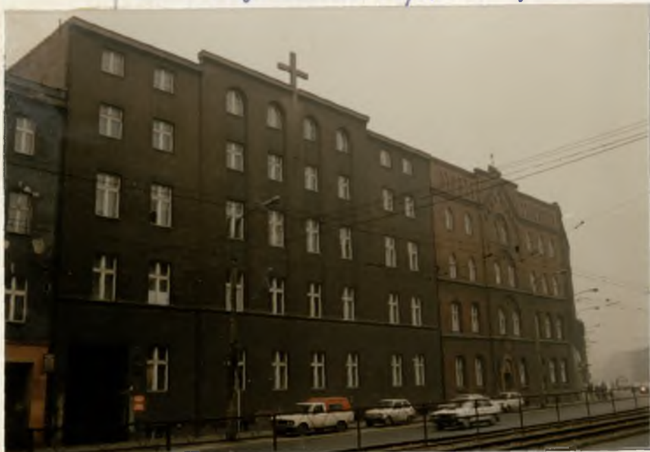
Dom Prowincjalny SS. Elzbiety w Katowicach przy ul. Warszawskiej
