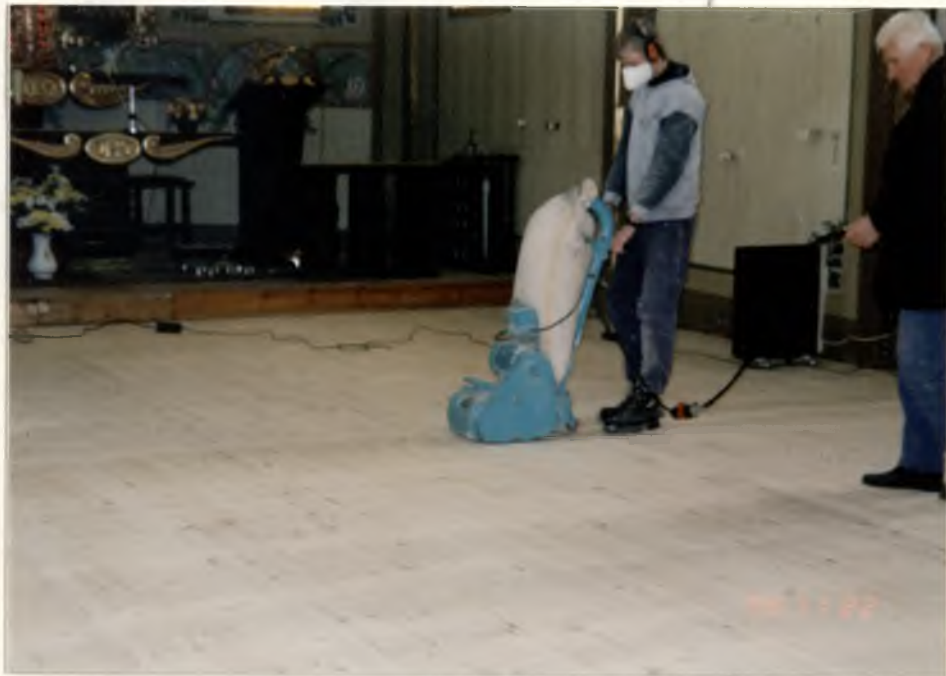
salirowanie podłogi a potem malowanie
