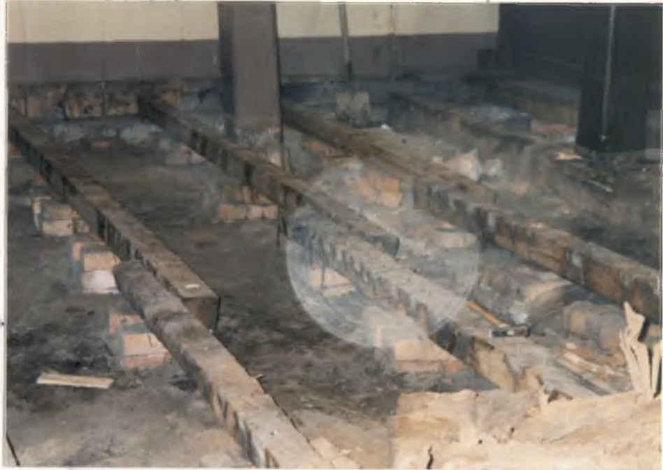
kuchnia, podparte kurtyki, cełkami, ten wymianione na płytę fundamentale betonowe.
