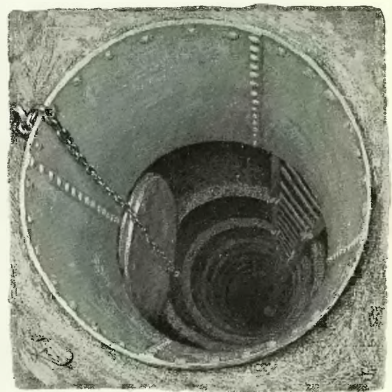
Aspect d'une cheminée d'accès à la chambre de travail, vue du sas à air.
