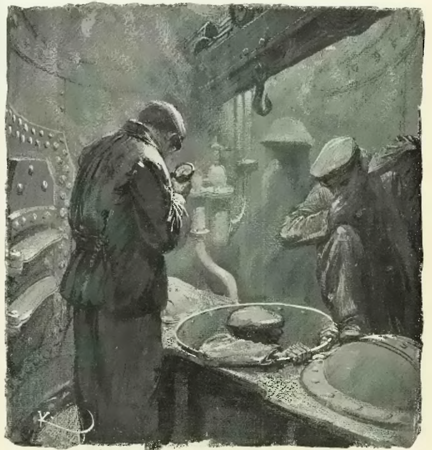
Dans le sas à air : l'éclusage avant la descente.
